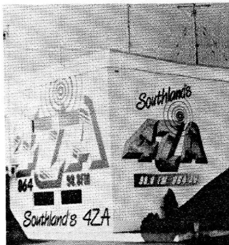
Del av radiostationen 4ZA:s byggnad i Invercargill. En av Radio New Zealands lokalstationer.
