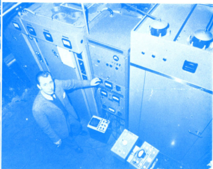
Sändarrum med 2 st. 10.000 Watts sändare av märket Continental.
